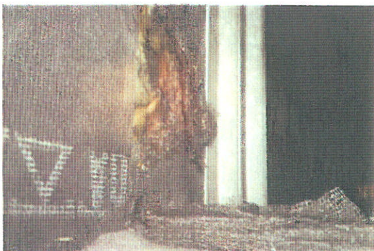
Photo 3 : Lieu de prélèvement de l'échantillon (paroi interne des conduits).
