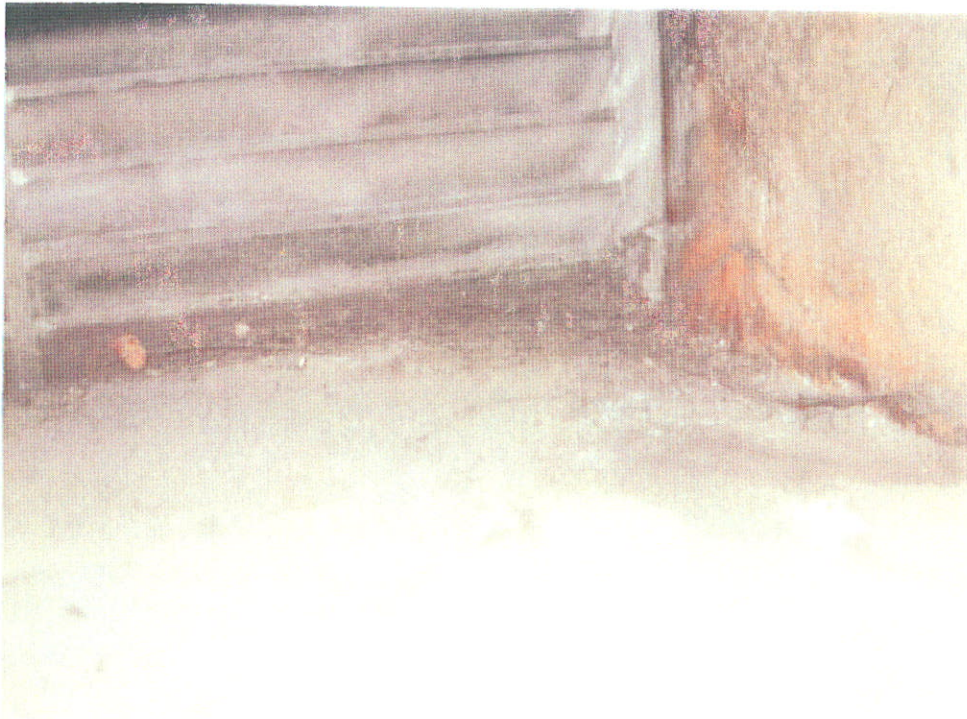
Conduit d'air frais
