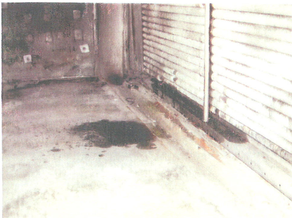
Cabinet des serpentins
