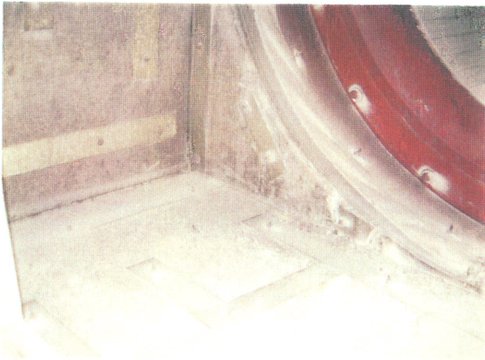
Cabinet du ventilateur d'évacuation
