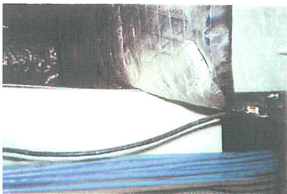
Photo 3 : Paroi externe du conduit
